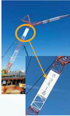
▲工事現場のクレーン
