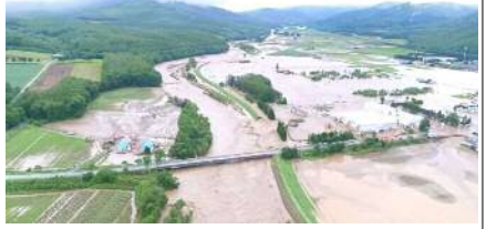
空知川の堤防決壊による浸水 (写真：国土交通省)
