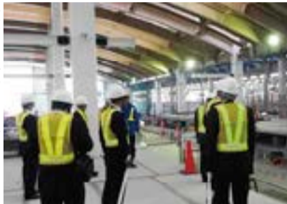
▲新潟市新潟駅在来線高架化工事視察
