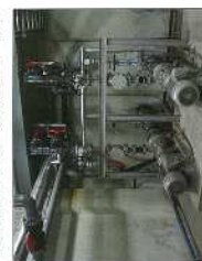
受入貯留設備 (破砕ポンプ)
