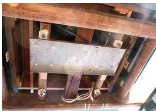
19 本神輿 基壇内部見上げ
