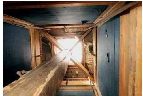
写真 6-7 花神輿 胴内部見上げ
