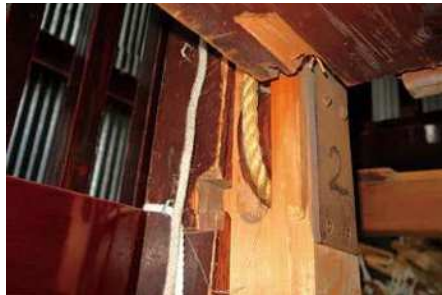
写真 4-3 安宅車 滑車受けと上山土台受けを兼ねた束(取替材)
