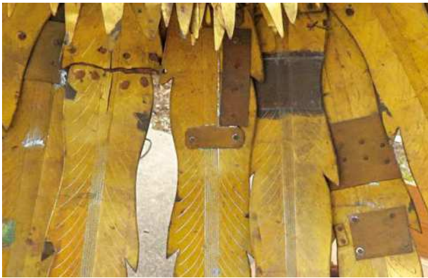
写真 7-18 旧鳳凰 尾羽根（部分）のからくり留め
