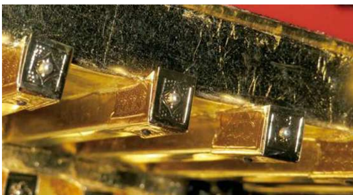
写真 7-12 飛檐垂木 垂木先小口金具
