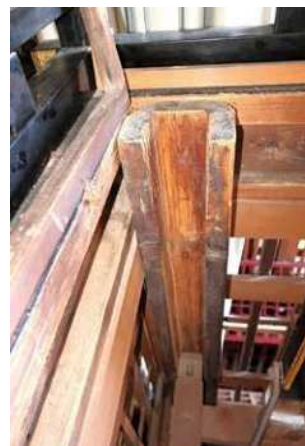
写真 4-7 若戎車 迫上樋と上山土台
