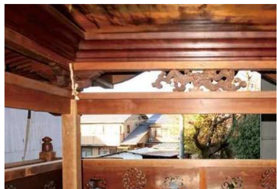
14 清影車 上山内部 柱上部
