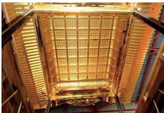
15 安宅車 上山内部 天井見上げ
