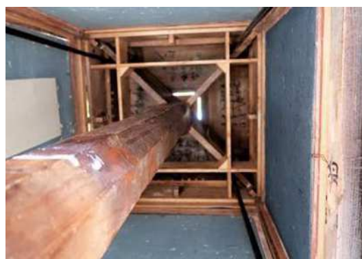
18 本神輿 洞内部見上げ (心柱)
