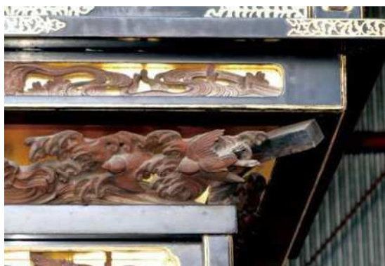
19 安宅車 前棚柱上正面隅
