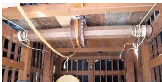
写真 4-21 若戎車の鯨巻き機構
