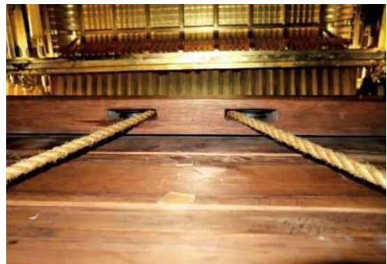
12 安宅車 下洞内部 上段滑車受け下端見上げ
