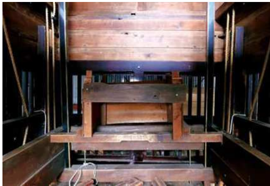
11 安宅車 下山内部 上山柱下部背面
