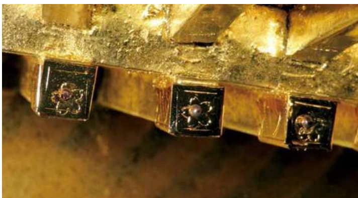
写真 7-13 地垂木 垂木先小口金具
