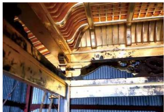
14 安宅車 上山内部 柱上部
