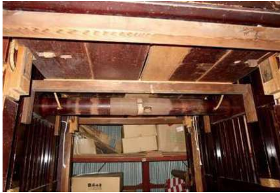
9 安宅車 下山内部 上段床見上げ 鯨巻き
