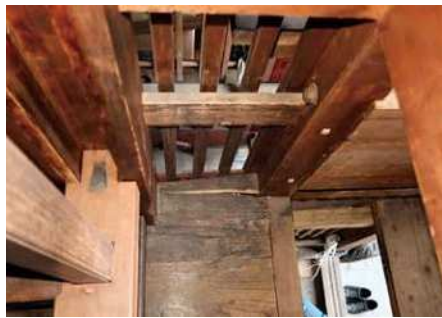
写真 4-14 清影車 迫上樋と上山土台
