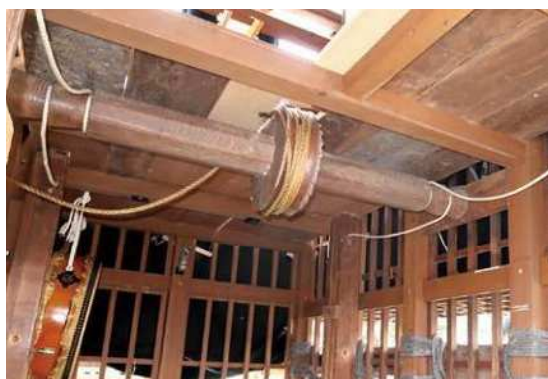
9 若戎車 下山内部 上段床見上げ 鯨巻き
