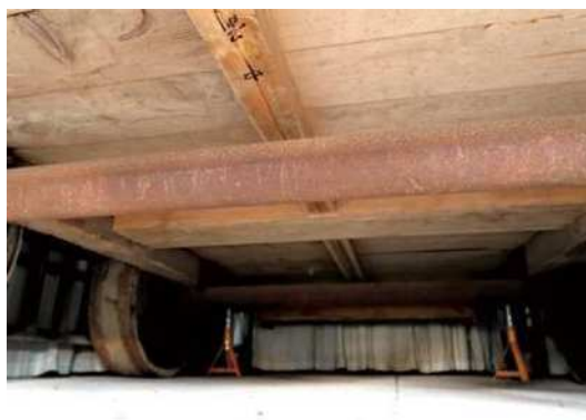
6 若戎車 下山床組見上げ
