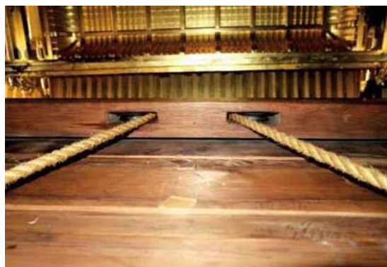
12 安宅車 下洞内部 上段滑車受け下端見上げ
