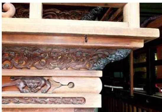
19 清影車 前棚柱上正面隅
