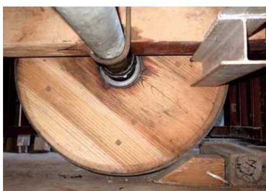
7 安宅車 下山車輪軸受け
