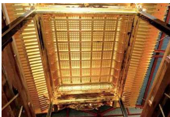
15 安宅車 上山内部 天井見上げ
