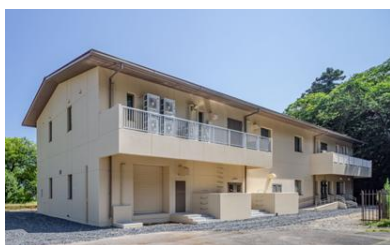
鏡岩水源地管理棟（改築中）
