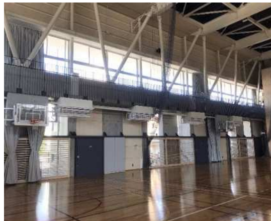
体育館空調設備整備（エアコン）
