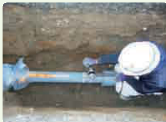
耐震管の布設(ダクタイル鋳鉄管 口径100mm)
