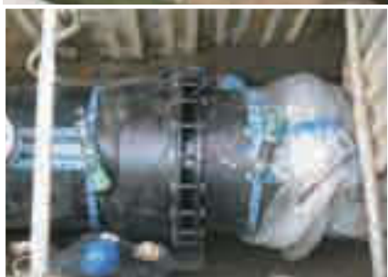
水道管(耐震管)の布設工事(口径900mm)
