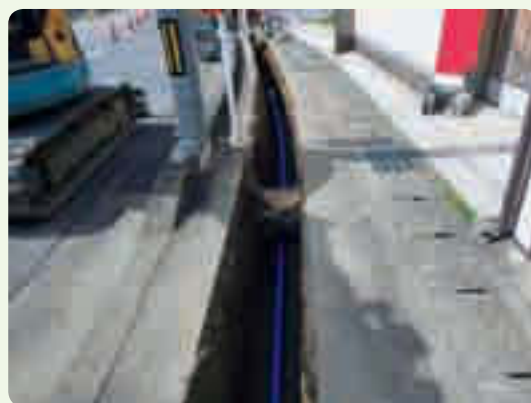
耐震管の布設(高密度ポリエチレン管 口径50mm)
