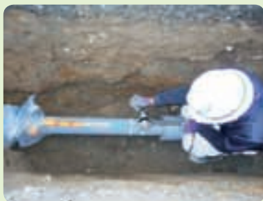
耐震管（水道）の布設
