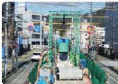
【下水道管の耐震化】
