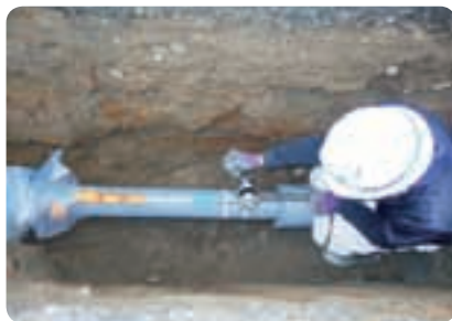
【水道管の耐震化】
