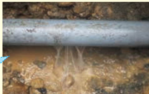
管のひび割れによる漏水
