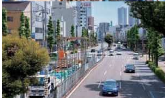
市内中心部での耐震管布設工事の様子
