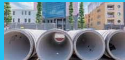
布設前の下水道管
