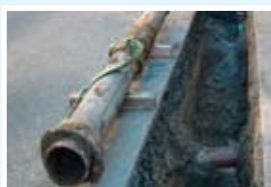
老朽化のため撤去された水道管
