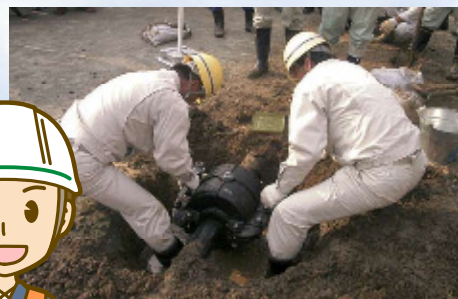
応急復旧訓練
