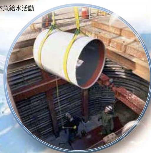
新設する鋼管の吊り込み作業
