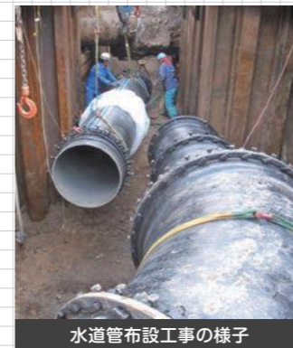
水道管布設工事の様子
