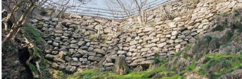
山上部通路の石垣
