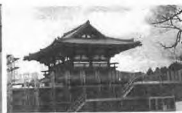
R5.1.20 素屋根解体
