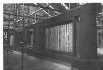
R3.3.4 二重 蓮子窓取付
