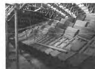
R6.3.13 瓦葺き状況
