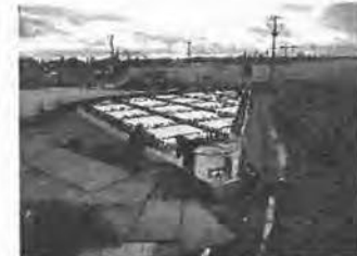
R 5.12.1 軽量地盤置換（上層部）
