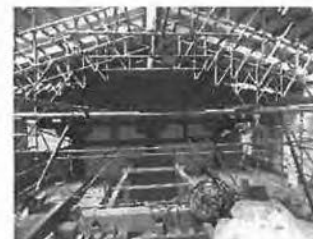
R5.8.31 素屋根内部
