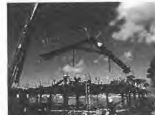
R 5.12.27 鉄骨梁据付
