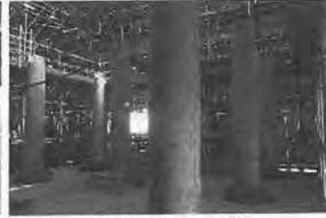
R2.11.4 建柱状況
