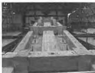
R6.2.20 素屋根内部
