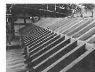
R6.2.26 素屋根内部
