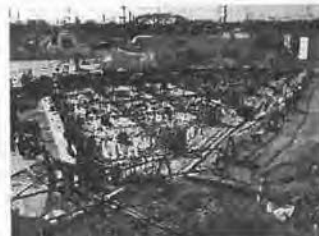
R 5.10.30 基礎梁配筋状況
