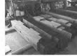
R6.2.13 築地塀の屋根部材
