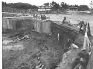
R 5.9.8 掘削状況
