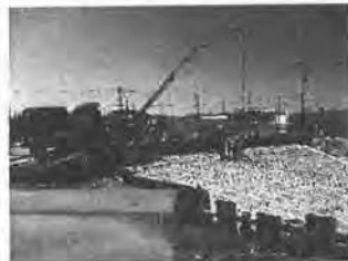
R 5.10.12 基礎コンクリート打設
