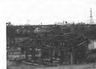
R 6.1.12 鉄骨工事完了
