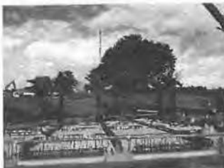
R 5.12.14 鉄骨柱建方
