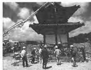
R5.6.26 基礎コンクリート打設
