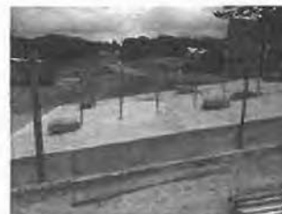
R5.7.25 基礎コンクリート完成
