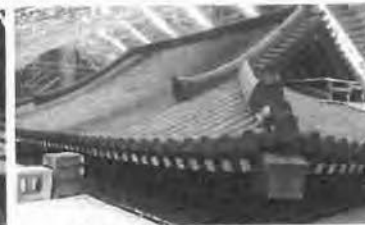
R4.4.13 二重屋根瓦葺
