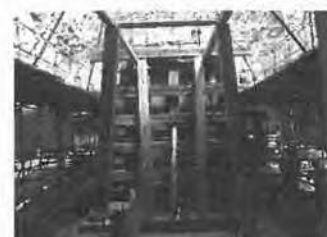
R5.8.3 版築型枠
