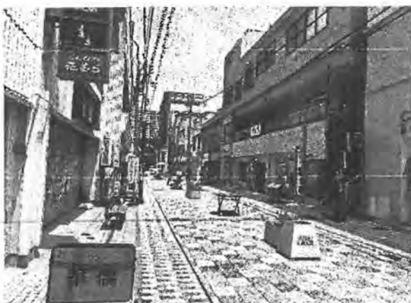
沼津市 アーケード撤去後商店街
