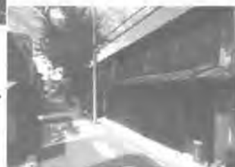
改修後の長屋外観▶
