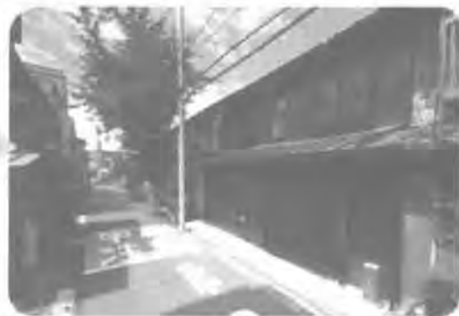
改修後の長屋外観
