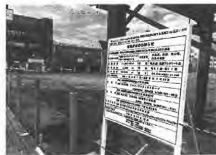
工事が始まった本庁舎跡地
