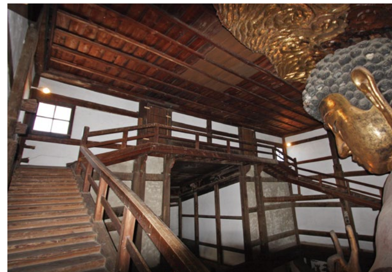
大仏殿内の斜路と観相台
