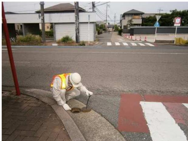
【路面の不陸（2箇所）、溜水を確認した仕切弁（11箇所）の音聴調査状況】
