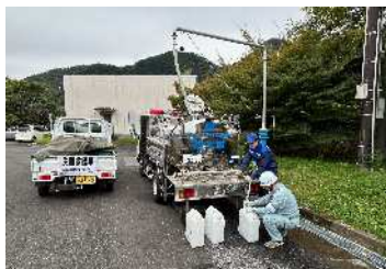
岐阜市指定管工事協同組合との合同訓練
