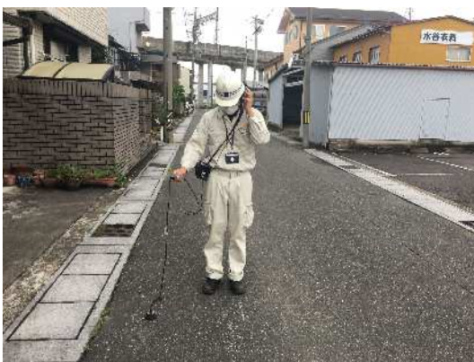
漏水探知機による路面音聴調査
