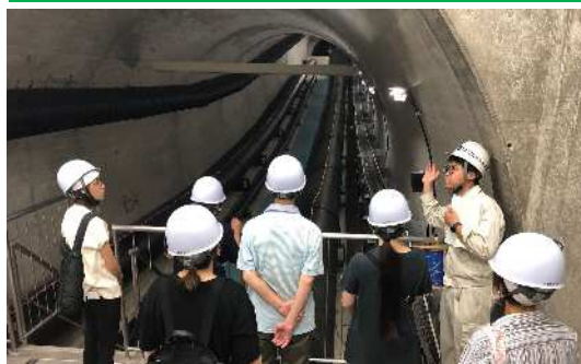
上下水道モニター事業（鏡岩配水池入口）
