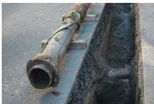
老朽化した水道管の撤去状況
