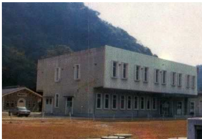
鏡岩水源地（建設当時）
