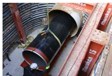
耐震化（パイプインパイプ工法）
