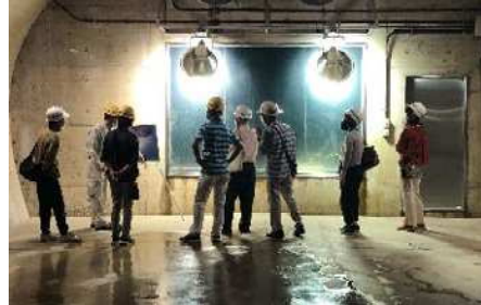
施設見学会の様子（鏡岩配水池）
