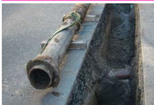
老朽化した水道管の撤去状況
