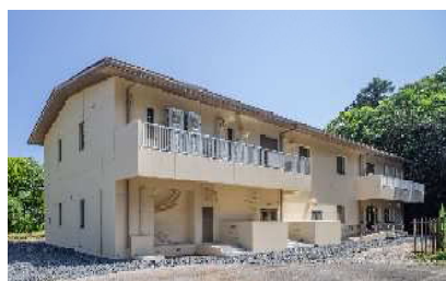
鏡岩水源地管理棟の耐震化
