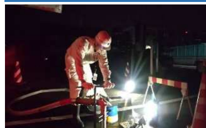
夜間洗管作業（消火栓開栓）
