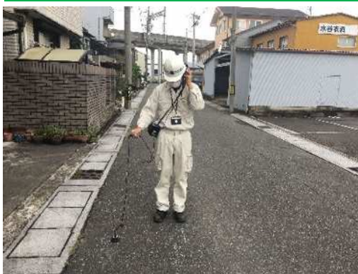
漏水探知機による路面音聴調査
