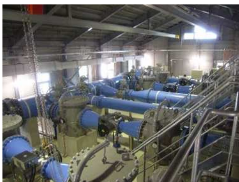
鏡岩水源地 紫外線処理装置
