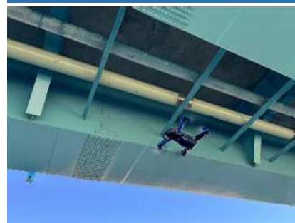
ドローンによる点検状況
