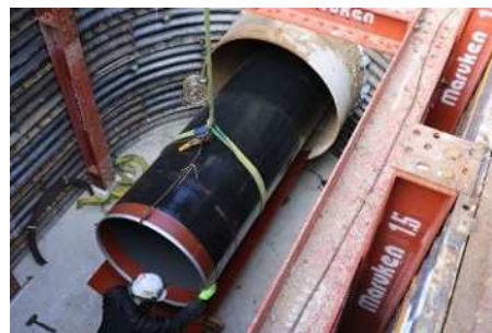
パイプ・イン・パイプ工法の施工状況
