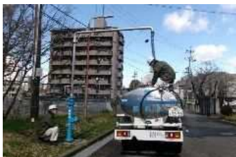
屋外給水用配管
