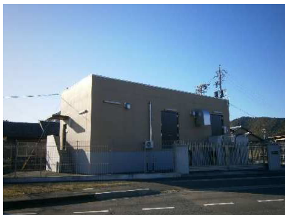
黒野第1 加圧施設
