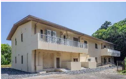
鏡岩水源地管理棟
