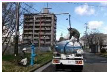
屋外給水用配管
