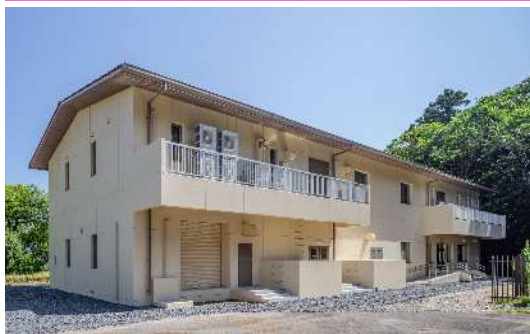
鏡岩水源地管理棟
