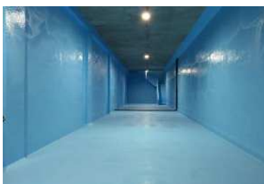
本荘配水池の耐震化
