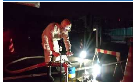
夜間洗管作業（消火栓開栓）
