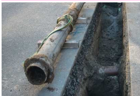
老朽化した水道管の撤去状況
