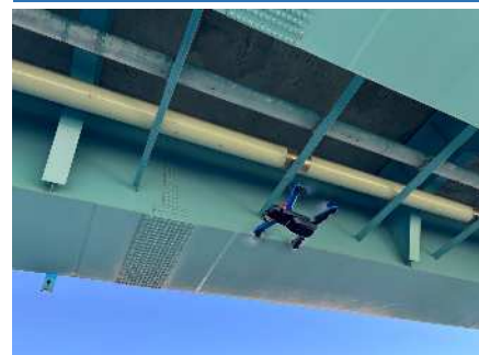
ドローンによる点検状況
