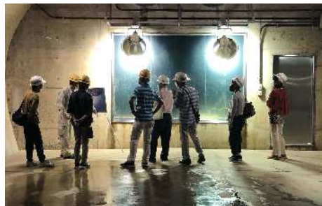
施設見学会の様子（鏡岩配水池）
