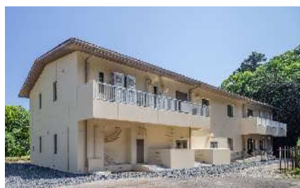
鏡岩水源地管理棟の耐震化
