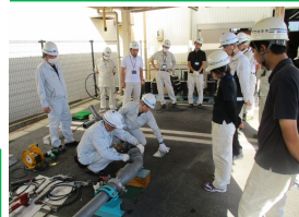
配水管技能講習
