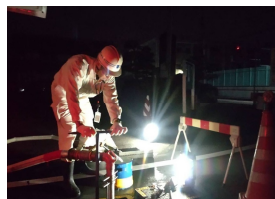
夜間洗管作業
