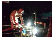
夜間洗管作業
