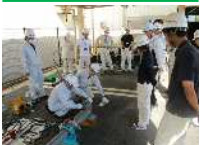
配水管技能講習
