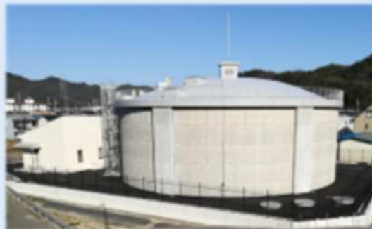
岩野田配水池
