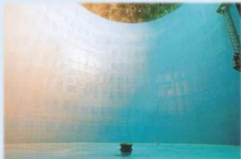
鏡岩配水池（内部）
