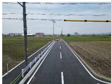
道路の現況写真
