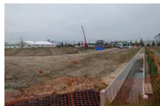
（株）光製作所の工事の様子
