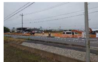
（株）岡本の工事の様子
