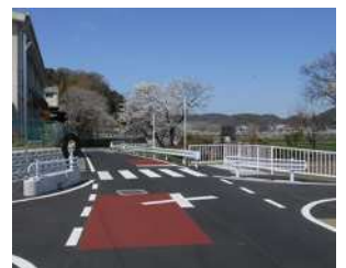
安全対策の実施
