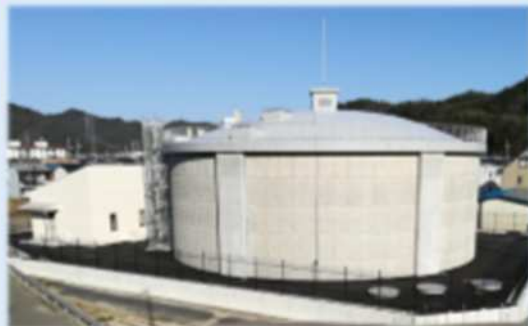
岩野田配水池
