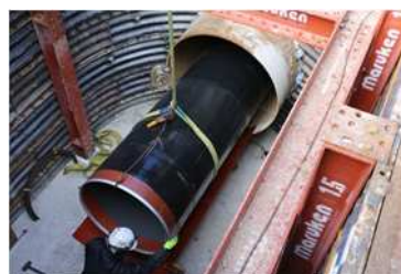
耐震化（パイプインパイプ工法）
