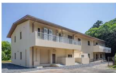
鏡岩水源地管理棟（改築中）
