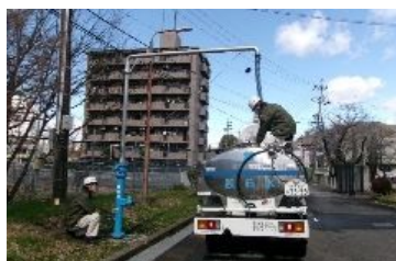
屋外給水用配管
