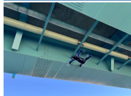
ドローンによる点検状況
