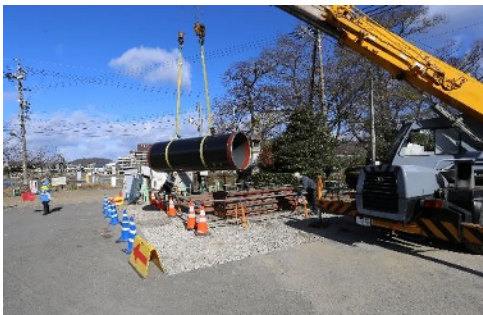
パイプ・イン・パイプ工法の施工状況
