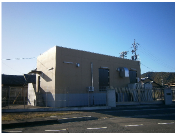
黒野第1 加圧施設
