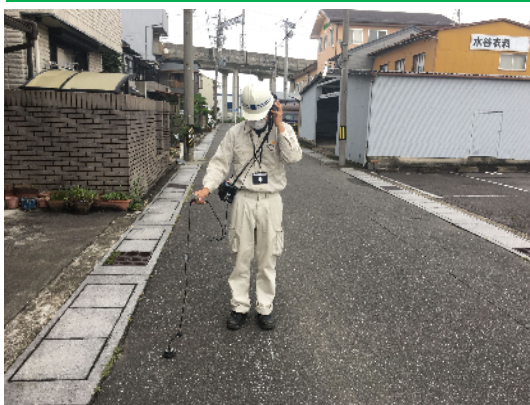
漏水探知機による路面音聴調査
