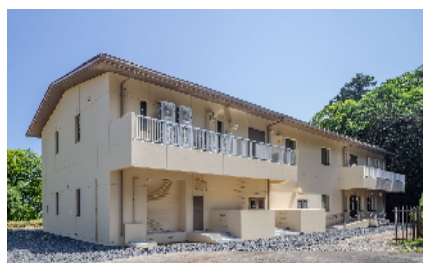
鏡岩水源地管理棟の耐震化
