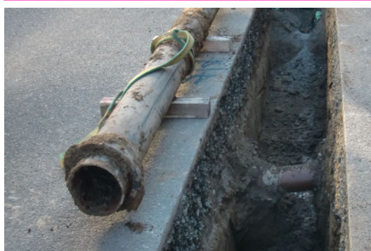
老朽化した水道管の撤去状況
