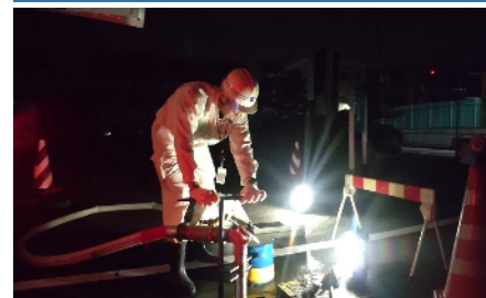
夜間洗管作業（消火栓開栓）
