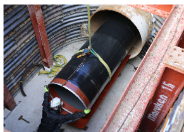
水道管の耐震化
