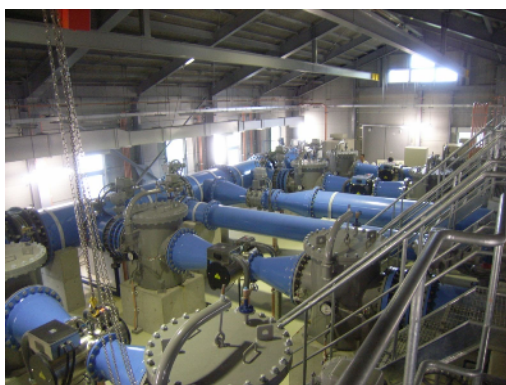
鏡岩水源地 紫外線処理装置
