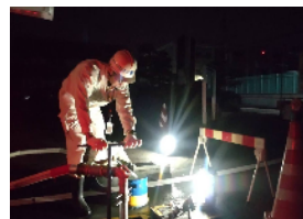
夜間洗管作業
