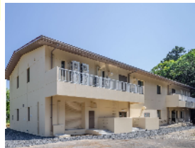
鏡岩水源地管理棟
