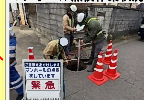
マンホール点検作業状況
