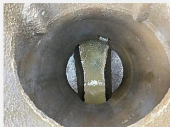
マンホール内 点検状況
