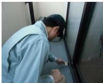
「外部（バルコニー）」調査の様子
