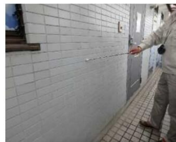
「外部（外壁）」調査の様子
