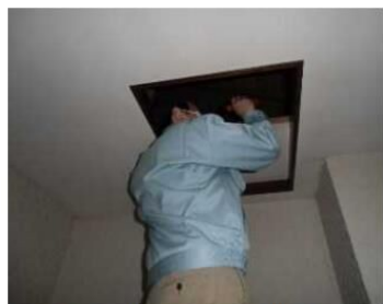
「小屋組・梁」調査の様子
