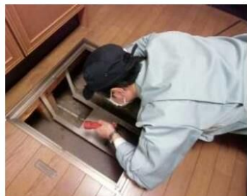
「土台・床組、基礎」調査の様子
