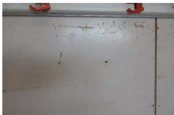
【教室壁】壁板の留め釘が浮き出る
