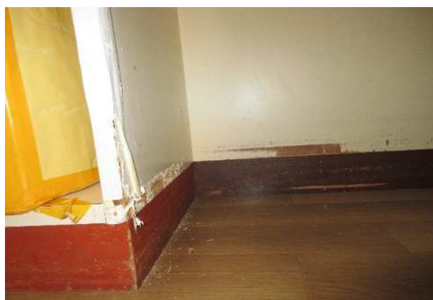
【教室壁】壁板の留め釘が浮き出る
