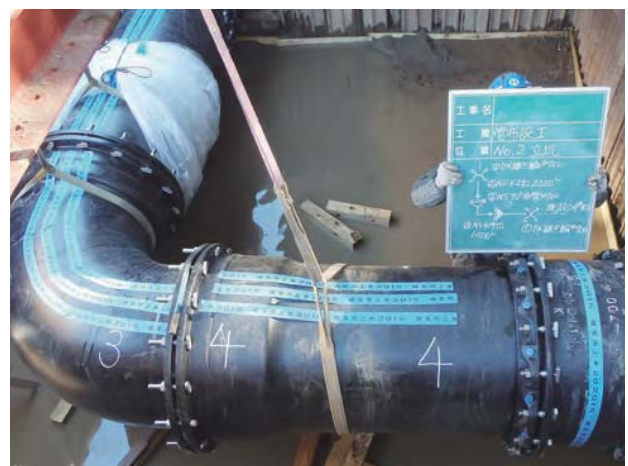
配水管(耐震管)の布設状況
