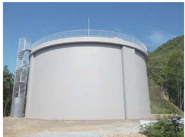
黒野第1配水池
