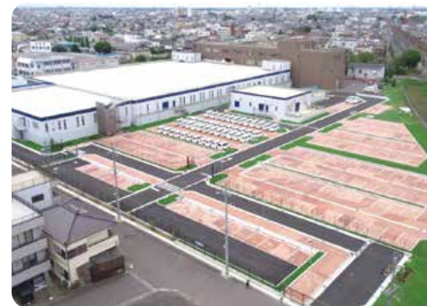
中部 プラント 上下水道事業部 本庁舎
