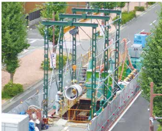
中部第1幹線管きょ布設工事（中部処理区）
