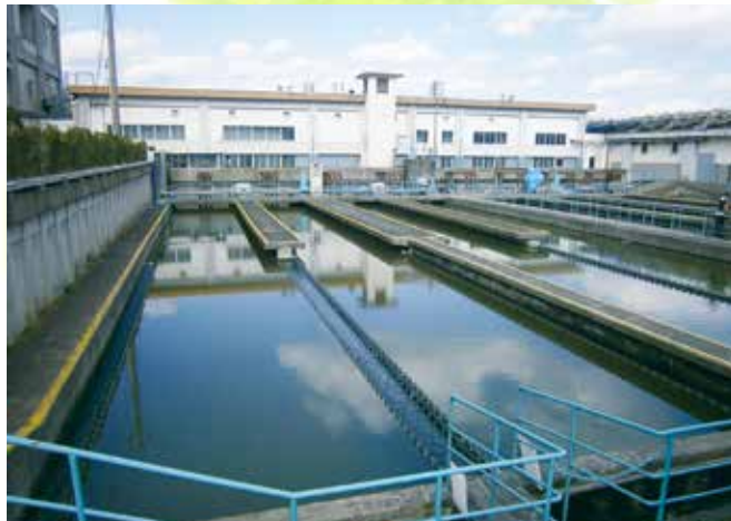
最終沈でん池(北部プラント)
