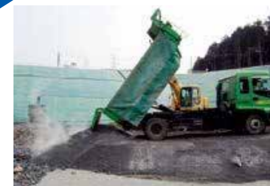
ごみを燃やして出た灰を埋めている様子
