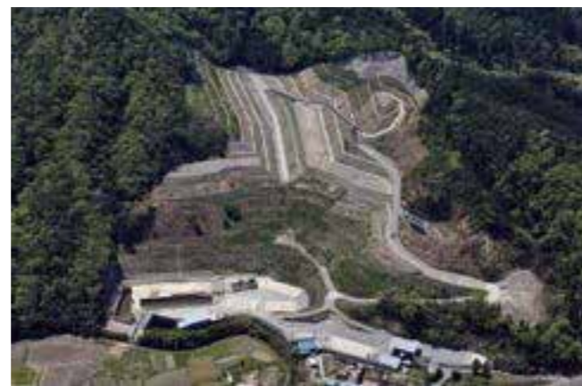
ごみを取り除いた後の現場（平成25(2013)年4月）
