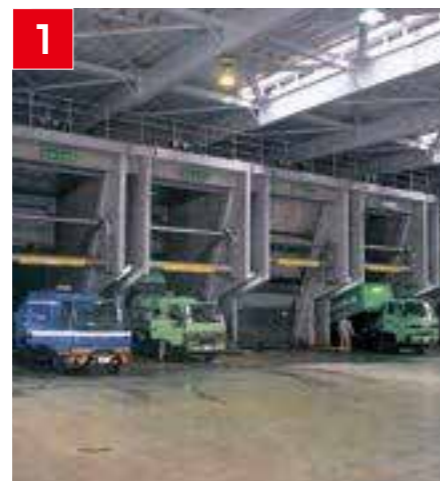
プラットフォーム ごみ収集車がごみピットへごみをおろします。
