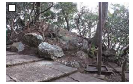
① 一ノ門に築かれた石垣です。岩盤の周囲に、石垣と巨石石垣を組み合わせでコーナー部分を造り出しています。構造や平面形が山県市にある16世紀前半に土岐氏によって築かれた大桑城の「岩門」と類似することから、後斎藤期に築かれたと考えられます。
