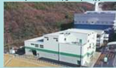
東部クリーンセンター (ごみの焼却場)
