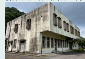
現在の管理棟 昭和48年竣工 (築50年)
