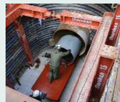
金華地区配水幹線布設工事
