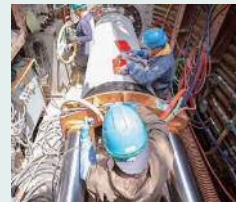
中部幹線バイパス管工事
