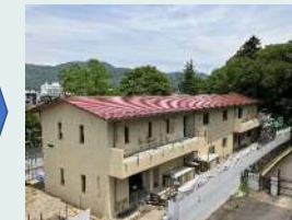
建設中の新管理棟 令和6年完成予定
