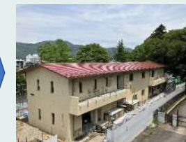
建設中の新管理棟 令和6年完成予定
