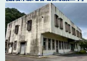
現在の管理棟 昭和48年竣工 (築50年)
