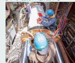
中部幹線バイパス管工事
