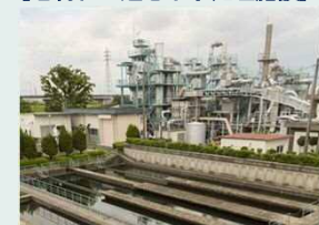
北部プラント 昭和41年供用開始 (築57年)
