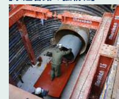
金華地区配水幹線布設工事
