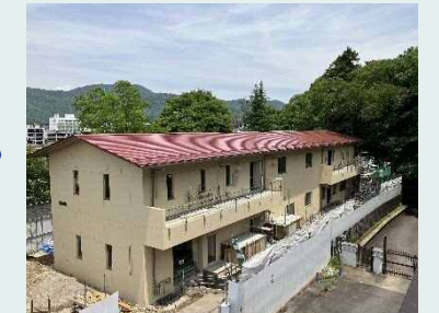
建設中の新管理棟 令和6年完成予定
