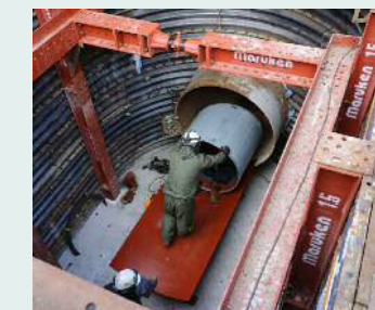
金華地区配水幹線布設替工事
