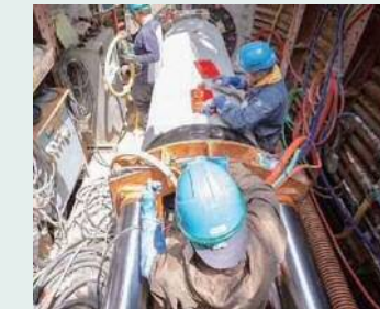
中部幹線バイパス管工事
