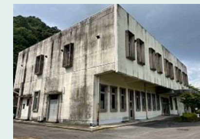
現在の管理棟 昭和48年竣工 (築50年)
