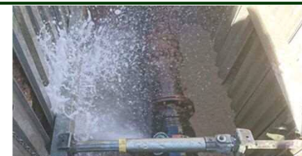
【老朽管からの漏水】
